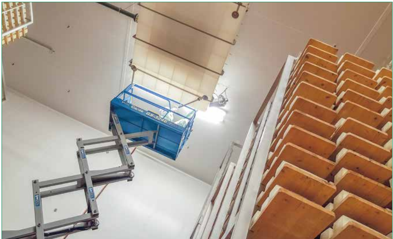
Listerien-Monitoring in einer Käseerei: Überprüfung der Klimaanlage
